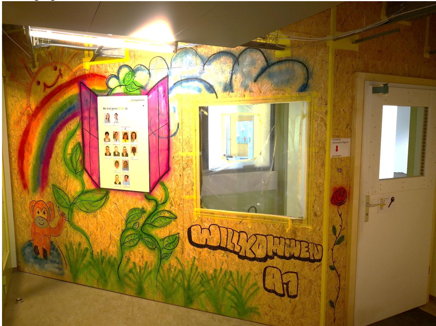
Der Eingang zum Baubereich im A1
