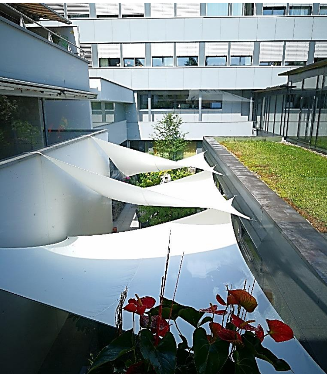
Blick von oben ins Atrium, den Innenhof
