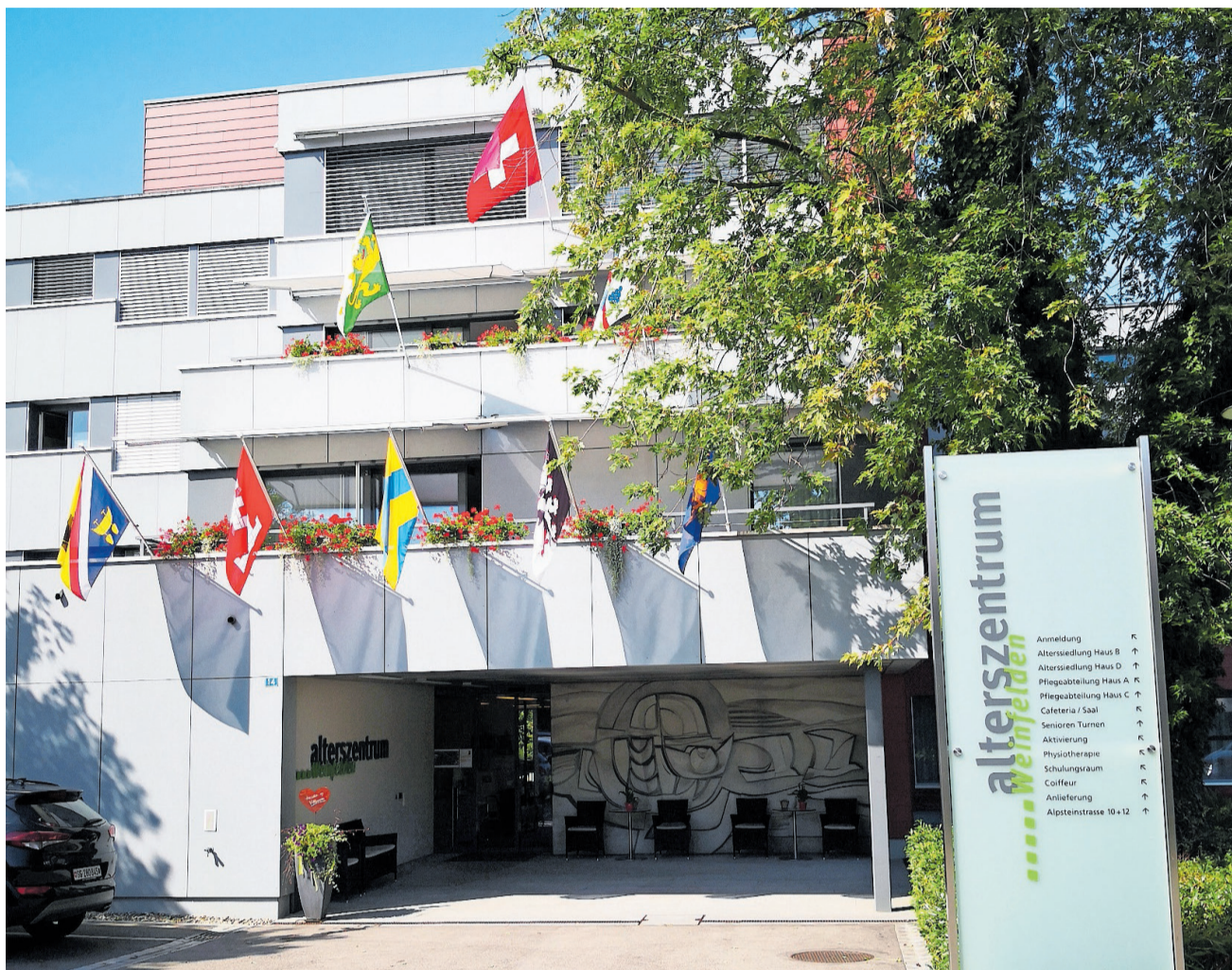
Die Brandschutz- und Erdbebensicherungen wurden unter laufendem Betrieb erneuert.
